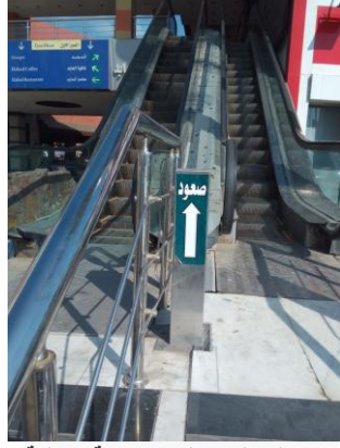
صورة (١٠) سلالم كهربائية داخلية الدراسة الميدانية ٢٠١٧/٧/٣١
