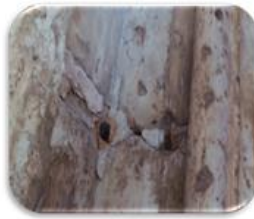
صور (10-11) توضح انفصال التكسيات عن الحائط نتيجة الى صدا كانت الحديد المستخدمه في تثبيت التكسيات عن الحائط نتيجة لتغير حجم الحديد بعد تعرضه
