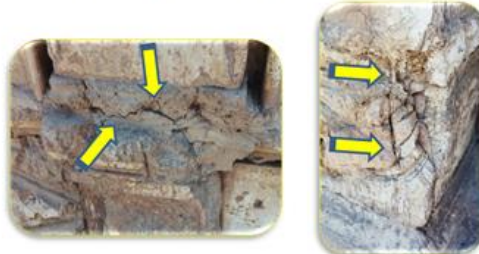
صور (12-13) توضح انفصال حبيبات الحجر واختزال في حجم الحبيبات وحدثت شروخ مختلفه في الاتجاهات المختلفه
