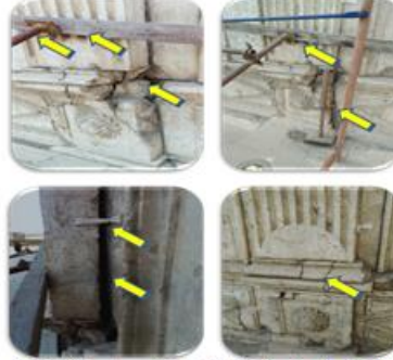
صورة (22-23-24-25) توضح شروخ و انفصال التكتيات الحجرية من الالباستر نتيجة لحدوث هبوط في التربة
