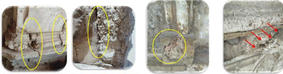
صور (6-7) توضح تشققات في الحجر نتيجة لاحتراقها على اكاسيد الحديد والصلصال والرمل ويتراوح ألوانها ما بين الاحمر والاصفر والاسود
