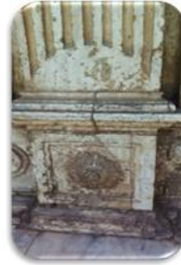
صور (10-11) توضح انفصال التكسيات عن الحائط نتيجة الى صدا كانت الحديد المستخدمه في تثبيت التكسيات عن الحائط نتيجة لتغير حجم الحديد بعد تعرضه
