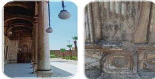
صورة (18) توضح التلف الناتج عن الأمطار الحامضية وتحول الطبقة السطحية للحجر الي قشرة صلبه سوداء صورة (19) توضح تكون طبقة من غبار الأتربة والطفلة وكاسيد الحديد (الباتينا) باللون البنى على الجزء الداخلى من العقود
