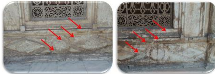
صورة (16-17) توضح تحول حبيبات الحجر الي مسحوقى بفعل فقدانها المادة اللاصقة بين حبيباتها وانفصالها نتيجة دورات الأذى والتلوث للملح
