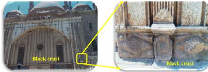
صورة (14-15) توضح تكون قشرة صلب على السطح الخارجى تعرف بظاهرة Black crust
