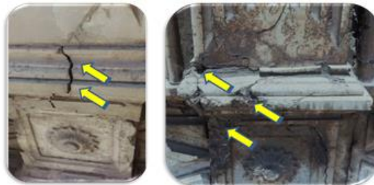
صورة (20-21) توضح التلف الناتج عن الأحمال الزائدة في التكتسيات الخارجية من شروخ وانفصالات
