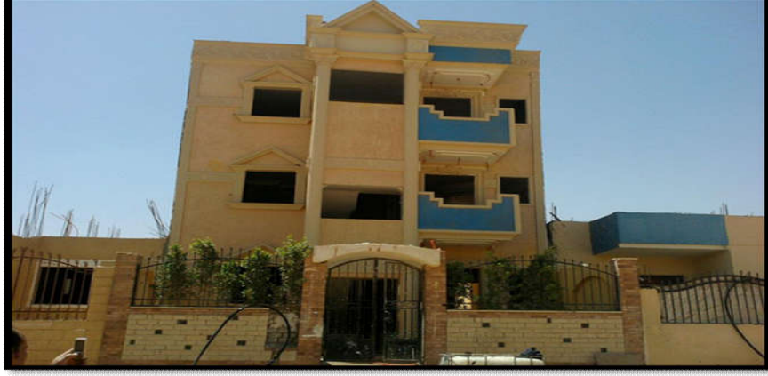
صورة (4) نموذج لمنزل في حي جنوب الأحياء السكنية 2015/5/16
