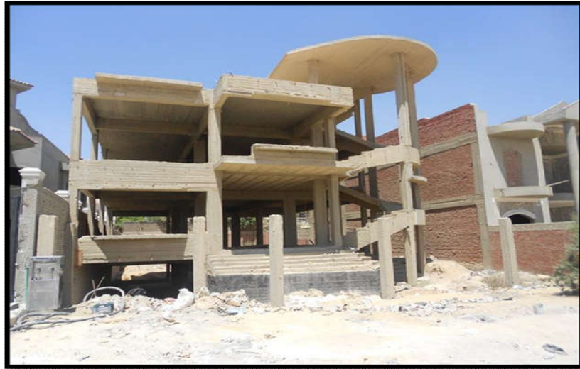
صورة (6) نموذج لإحدى الفيلات المشيدة بأعمدة خرسانية في حي التوسعات الشرقية . 2015/5/15
